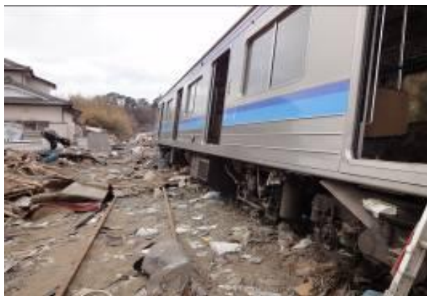
津波被害を受けた仙石線野蒜駅周辺を訪問
